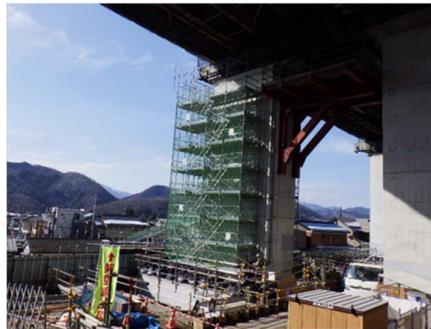
〔相模湖高架橋下部工工事状況〕 写真:2024年1月 現在の状況:躯体拡幅工事中
