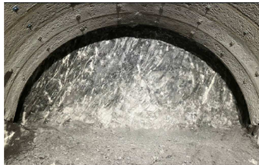
〔新小仏トンネル(仮称)掘削状況]写真:2024年1月 掘削進捗:約700m(2023.8)→約1,000m/約2,300m(2024.1)
