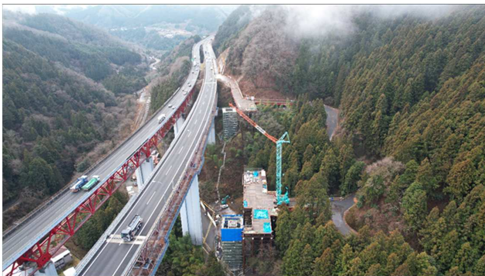
〔新底沢大橋(仮称)工事状況 写真:2024年1月 現在の状況:下部工工事中
