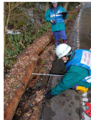
(能登町内での被災状況調査)
