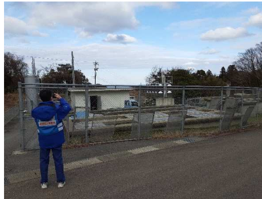
(珠洲市折戸浄水場の現地確認)
