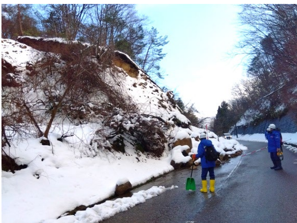
被災状況調査（崩壊した道路路面）【1月27日】
