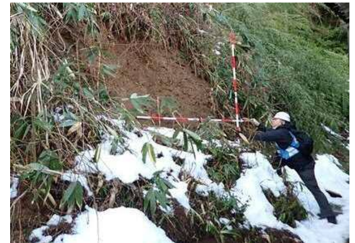
(輪島市内での被災状況調査)
