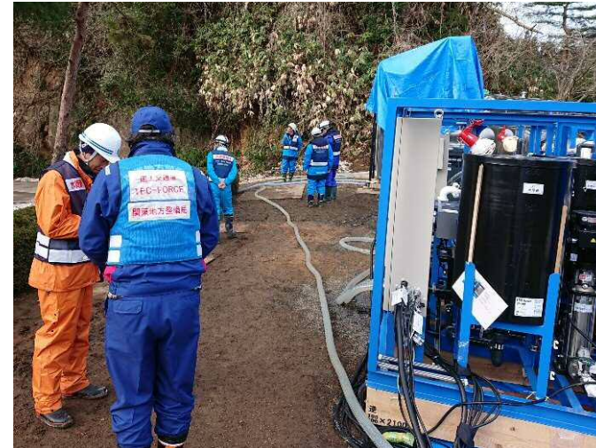
(珠洲市内での給水作業)
