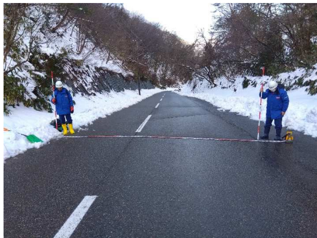
(能登町内での被災状況調査)
