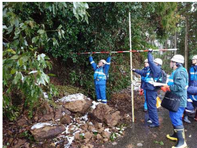
(能登町内での被災状況調査)
