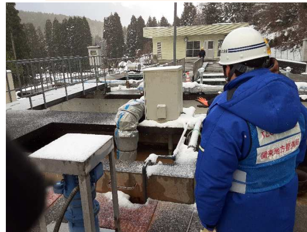
(珠洲市宝立浄水場の復旧状況確認)
