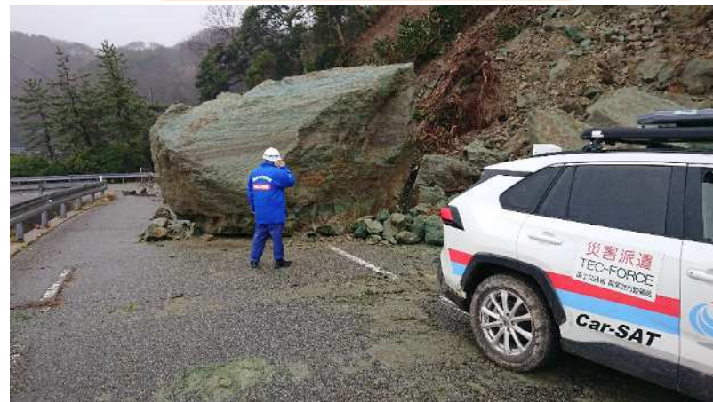
(珠洲市内での被災状況調査)
