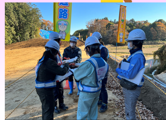
路体盛土現場確認
