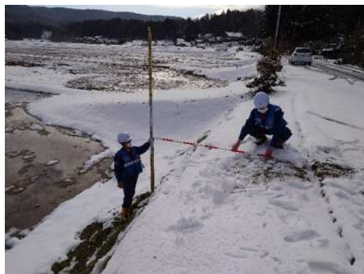
(志賀町内の被災状況調査)
