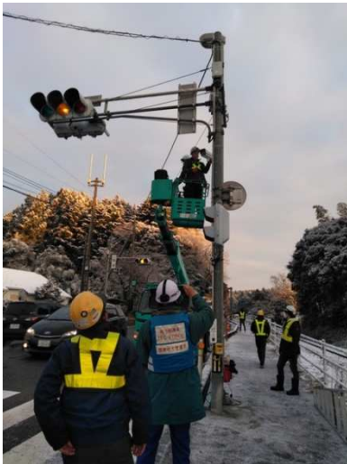
(志賀町内の被災状況調査・AIカメラ設置状況)
