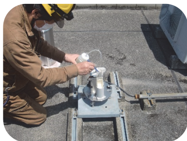
水文・水理観測機器の点検補修
