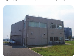
大師河原河川防災ステーション
