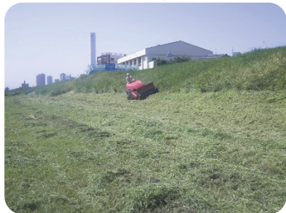
堤防の除草作業
