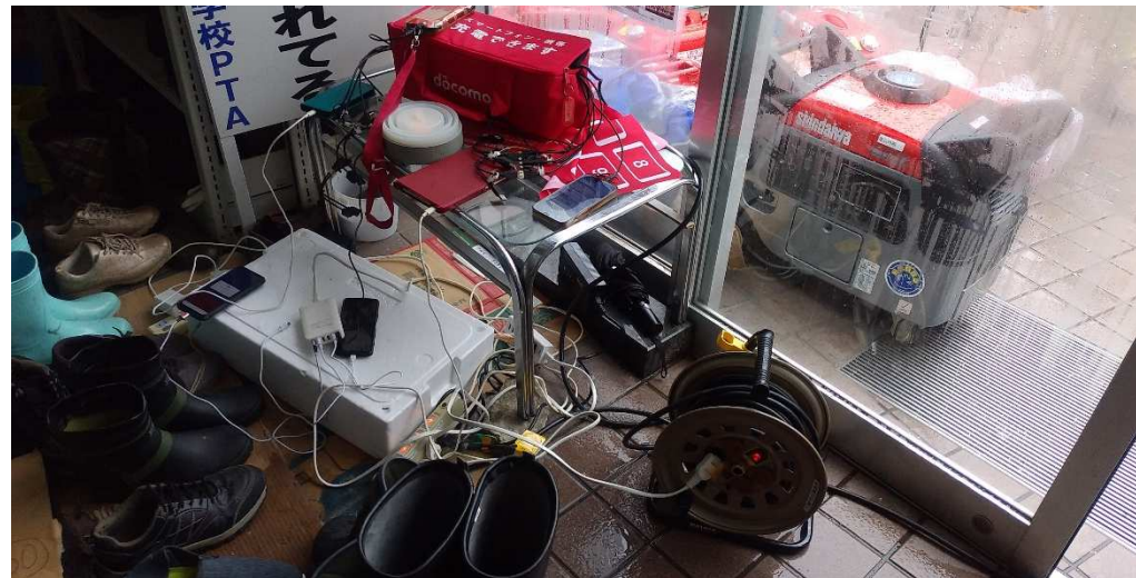
(輪島市内公民館で照明車を活用し、電源供給作業を実施)
