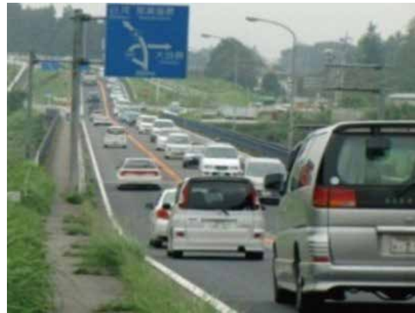
野崎橋付近（野崎橋南詰より福島方面を望む）
