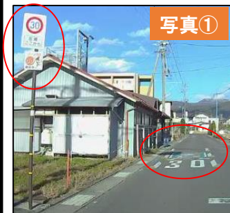
ゾーン30入口対策 (標識・路面標示)
