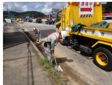
人力土砂回収 土砂多量による
