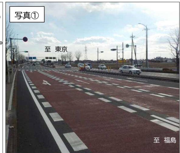
▲対策後の状況
