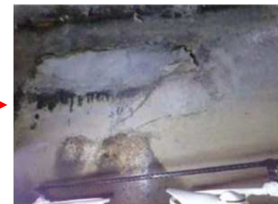
令和4年度点検状況(変状無し)
