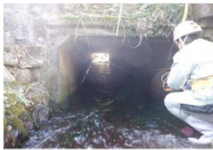
点検実施状況
