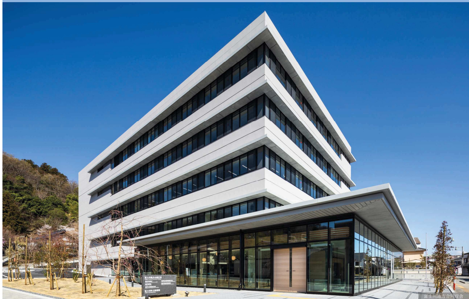
富士川地方合同庁舎
