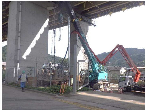
〔相模湖高架橋下部工工事状況〕 写真:2023年8月 基礎工事着手(2022.9)→躯体拡幅工事中(2023.8)
