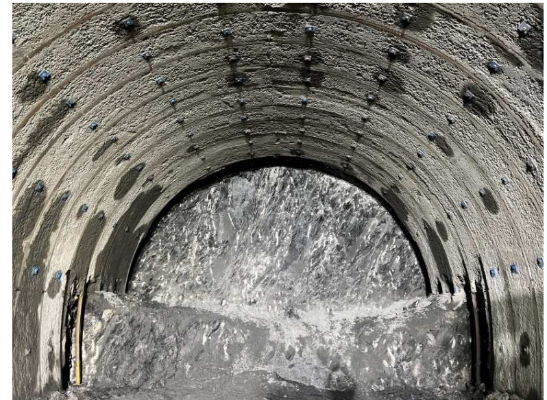
〔新小仏トンネル(仮称)掘削状況〕写真:2023年8月 掘削進捗:約130m(2022.9)→約700m/約2,300m(2023.8)
