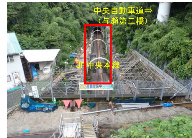
〔JR近接箇所防護工工事状況〕 写真:2023年8月 協定締結協議(2022.9)→準備工事着手(2023.8)
