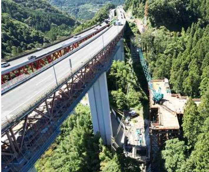
〔新底沢大橋(仮称)工事状況〕写真:2023年8月 昨年からの進捗:下部工工事に着手
