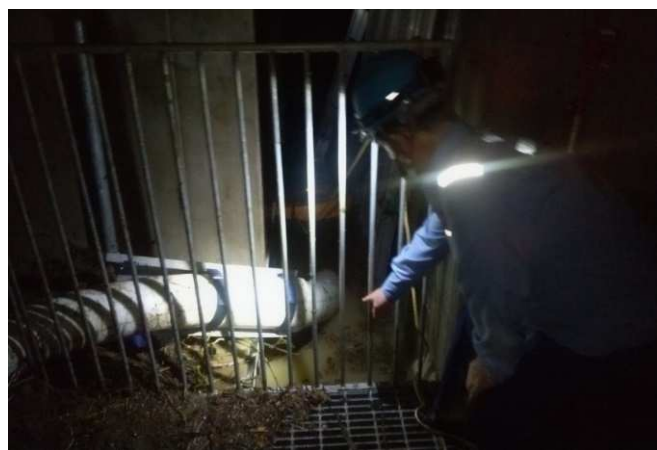
排水ポンプ車排水の状況 (日立市役所地下駐車場)
