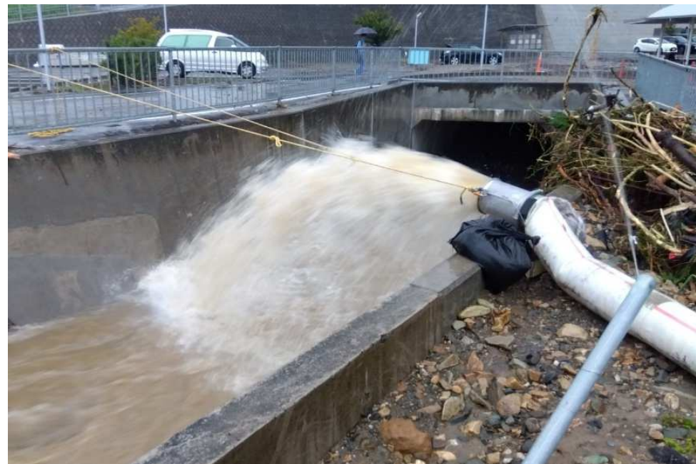
数沢川への排水状況
