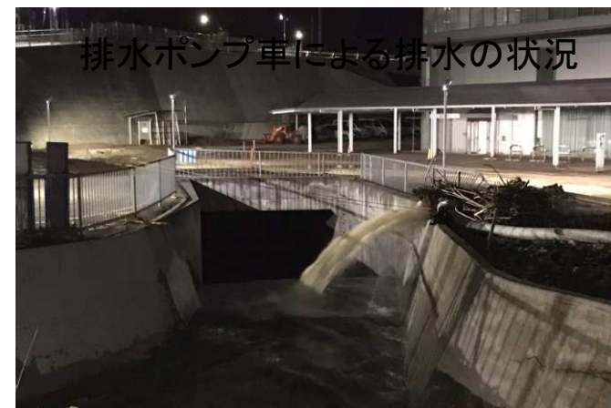
数沢川への排水状況
