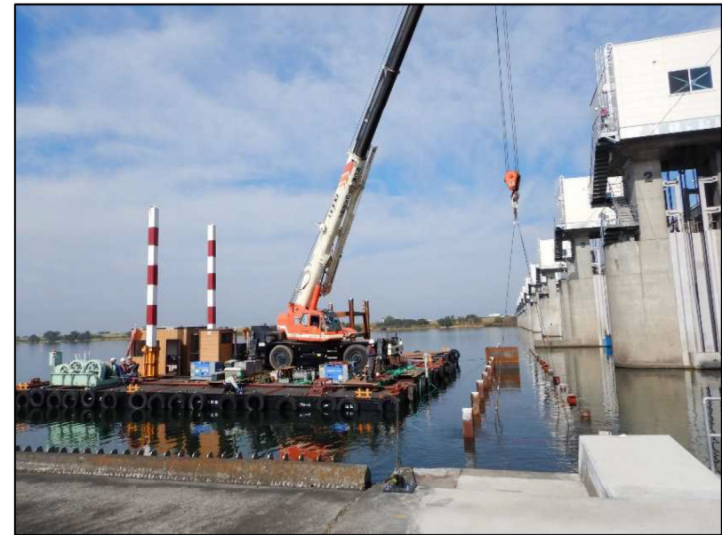
上流側 仮締切設置状況（クレーン台船）
