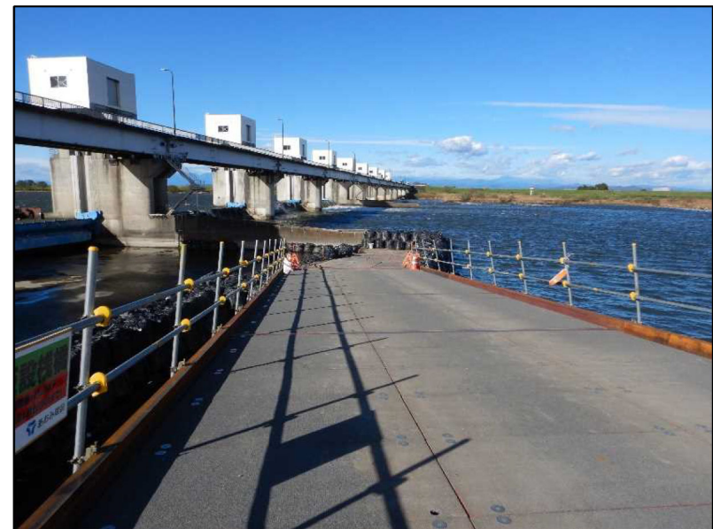
下流側 仮締切設置状況
