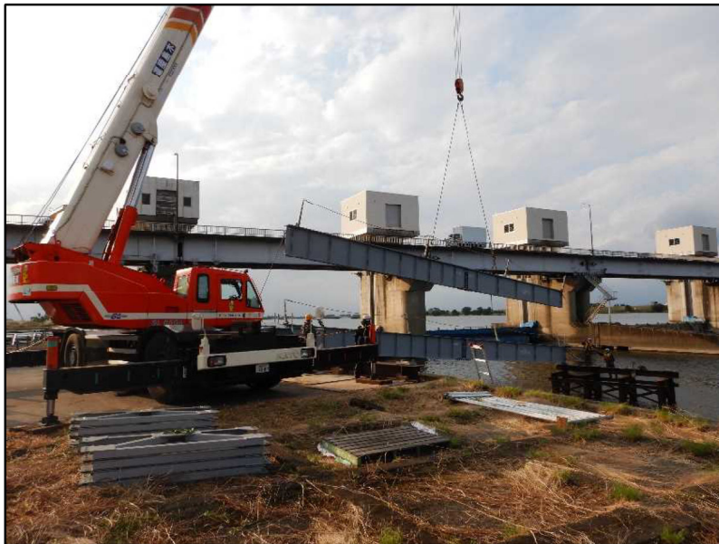
仮栈橋設置状況
