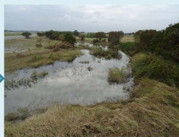
2019.10.24(台風19号による出水後)
