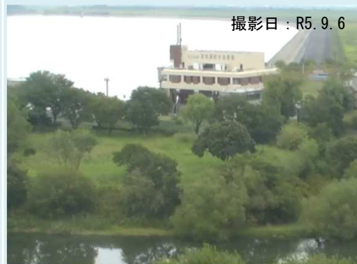
渡良瀬貯水池
