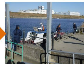
板橋緊急用船着場岸
