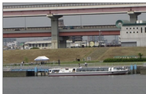
ポンツーン(浮棧橋)型 （左岸/堀切緊急用船着場（葛飾区））
