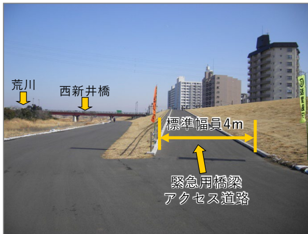
緊急用河川敷道路⇒天端道路 (右岸/西新井橋上流側)
