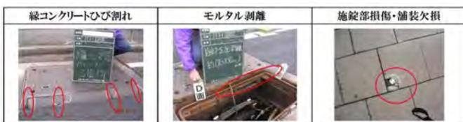
図 3-2 鉄蓋(上蓋・受枠)の損傷例
