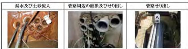
図 3-4 特殊部(管路取付部)の損傷例
