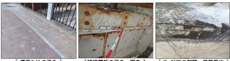
[橋面タイルの浮き] [補強鋼板の浮き・腐食] [アーチリブの剥離・鉄筋露出]
