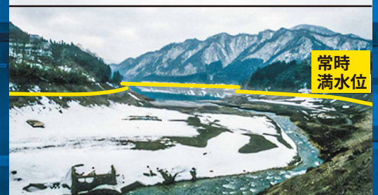
平成9年冬渇水 相俣ダムの様子
