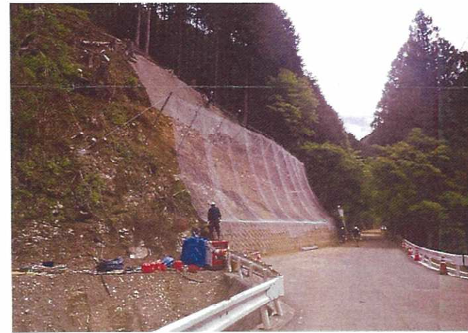
神ノ川林道 山の神先 土砂災害 工事現場(完成)
