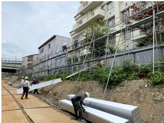
【防音パネル解体、L型擁壁設置着手前】6/13撮影
