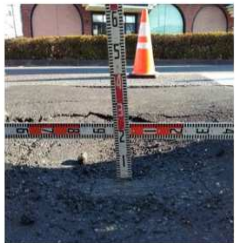
道路の陥没状況 (長さ1.5m×幅1.7m×深さ0.17m) ※R4.1.25 9時撮影
