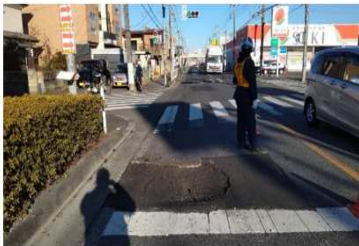
道路の陥没状況 (長さ1.5m×幅1.7m×深さ0.17m) ※R4.1.25 9時撮影
