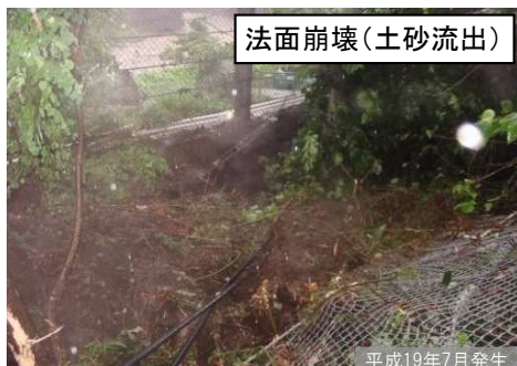
局地的大雨による法面崩壊状況
