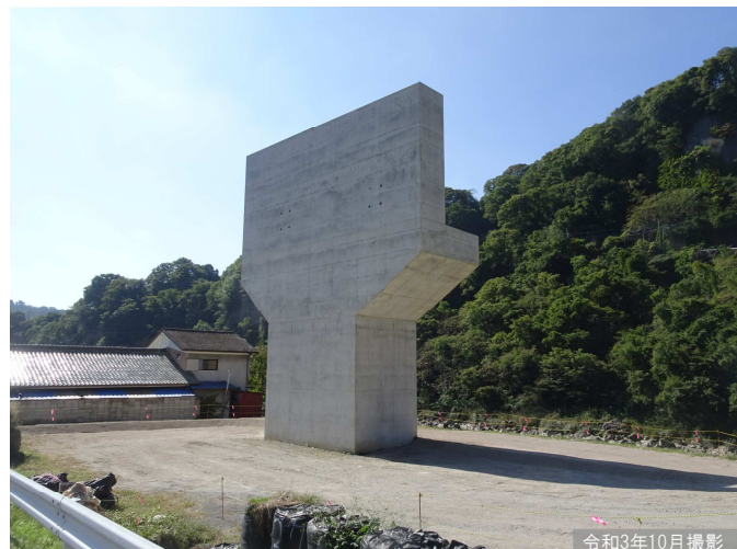
①棚下地区の橋梁下部工事施工状況
