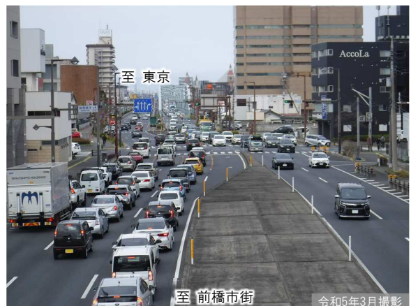
②桃井虹色橋から群馬大橋方面の状況
