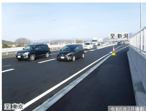
①国道17号・18号合流部（拡幅区間）
