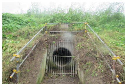
上池T 口の作業後
