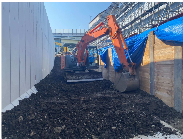
【逆T型擁壁埋戻し工着手前】4/21撮影
