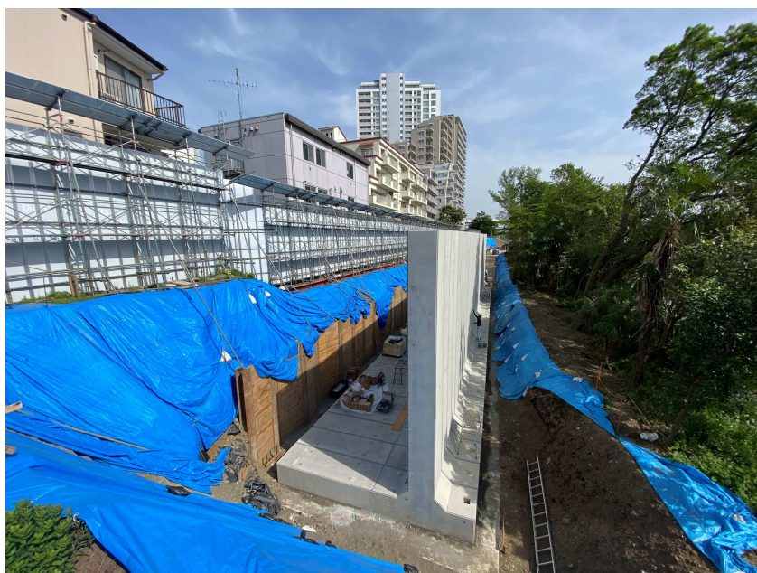
【逆T型擁壁埋戻し工着手前】4/21撮影
