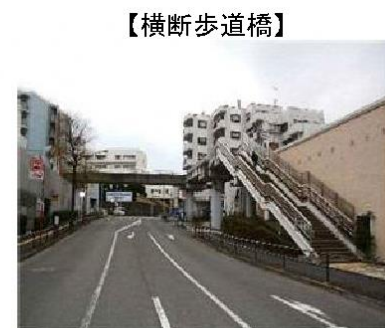
(永山駅北口歩道橋)
