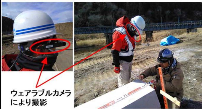
現場での受注者による撮影状況
