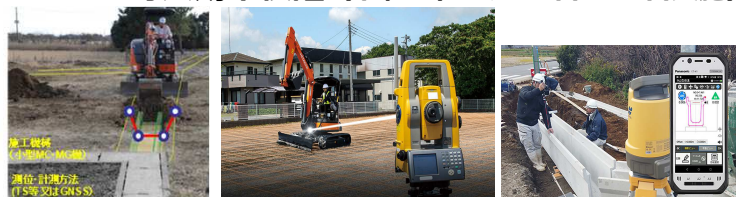
小型施工機械へのICT導入、小規模な現場での3次元設計データ利活用を検証
