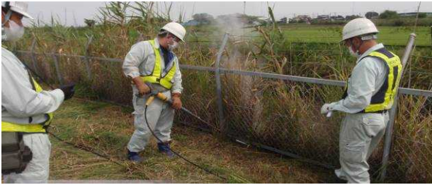
写真-1 ノズルを用いた温水除草
