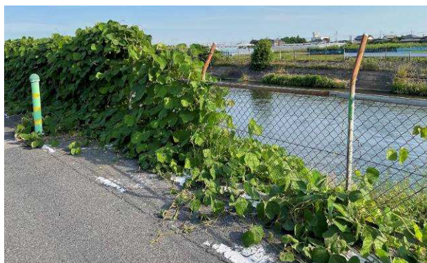
写真-8 葛（施工後8か月経過）
