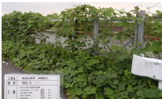
写真-7 葛（施工前）
