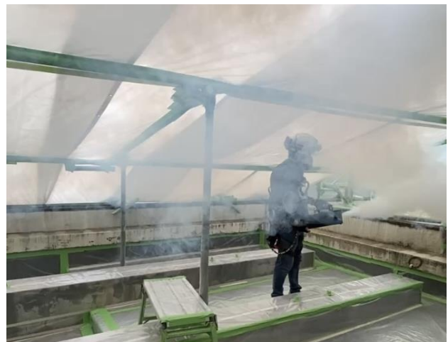
図5 スモークマシーンをを用いた負圧隔離養生の確認
