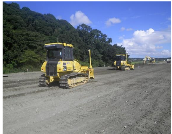
写真-2 盛土敷均し施工状況
