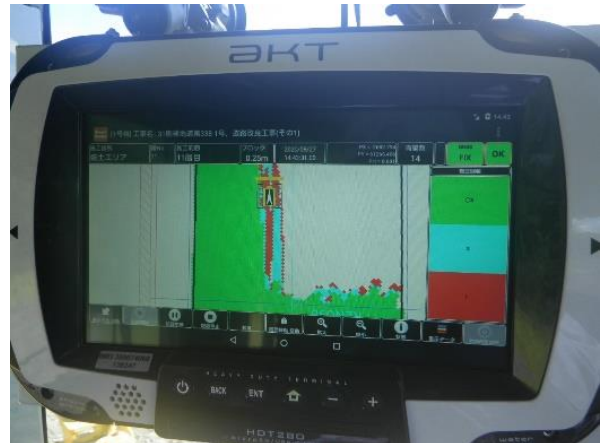
写真-3 盛土転圧状況モニター
