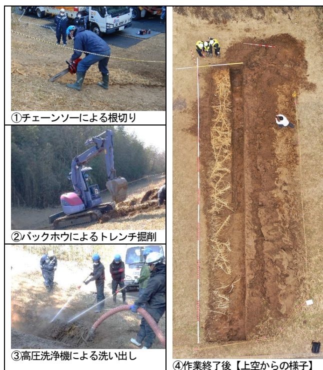
図-5 開削の状況
