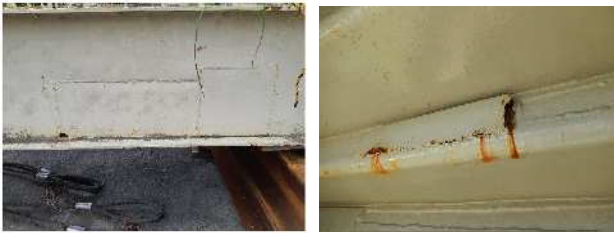
図-8 当て板補修
