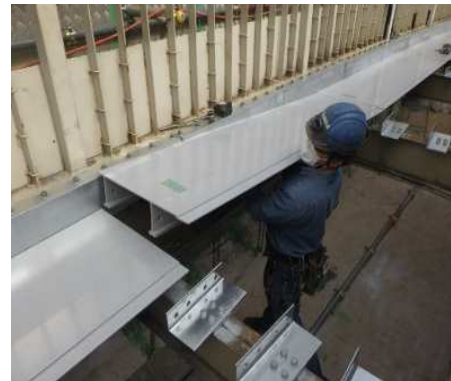
図-11 高耐食性材料の床版への更新
