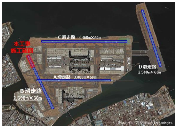
図-2 東京国際空港B滑走路舗装改良工事施工位置
