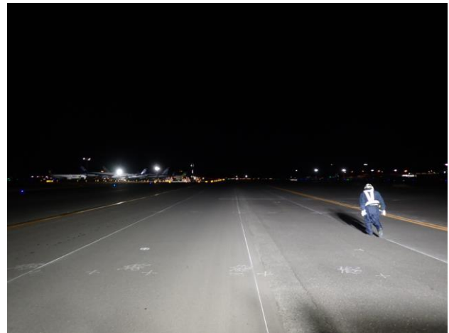
写真-3 マーキング作業（従来工法）
