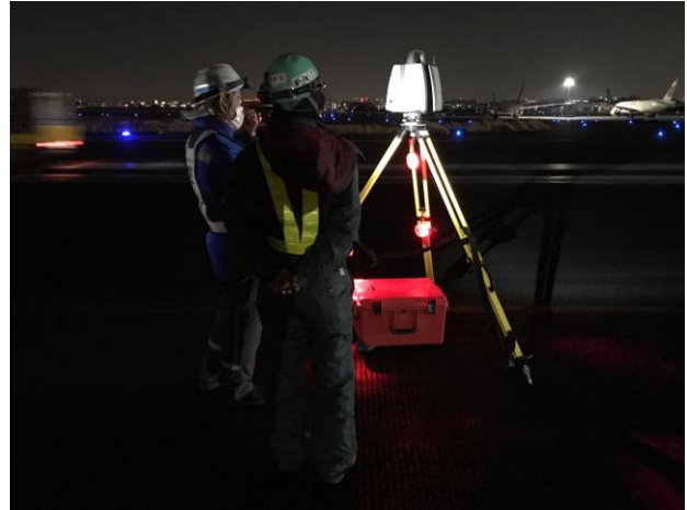
写真-1 3次元起工測量
