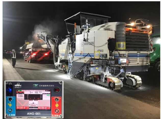
写真-2 ICT路面切削 (MC方式)
