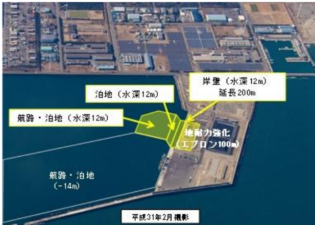
図3 外港地区施工箇所
