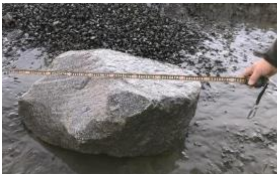
図7 鋼管矢板内地中障害物
