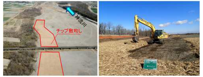
図-12 チップ敷均しの状況
