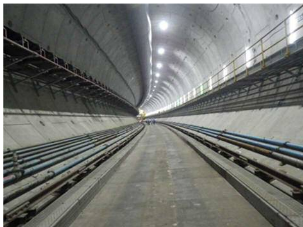
図-7 トンネル坑内
