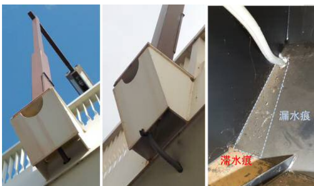
図-3 照明配線管開口部の状況
