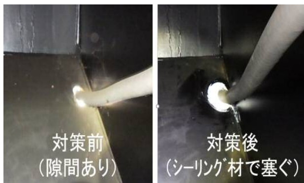
図-5 箱桁内部からの対策状況
