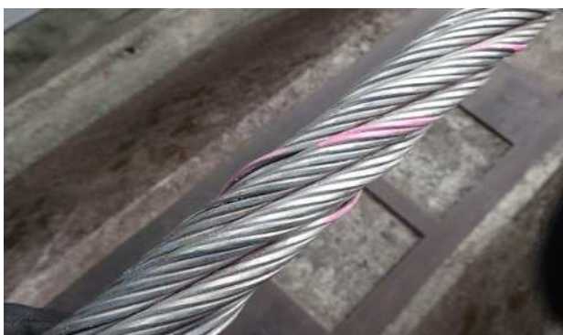
図-2 ワイヤーロープ素線の浮きの状況
