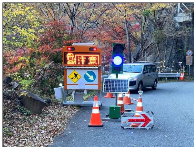
写真-4 仮設信号機（ケーブルレス）
